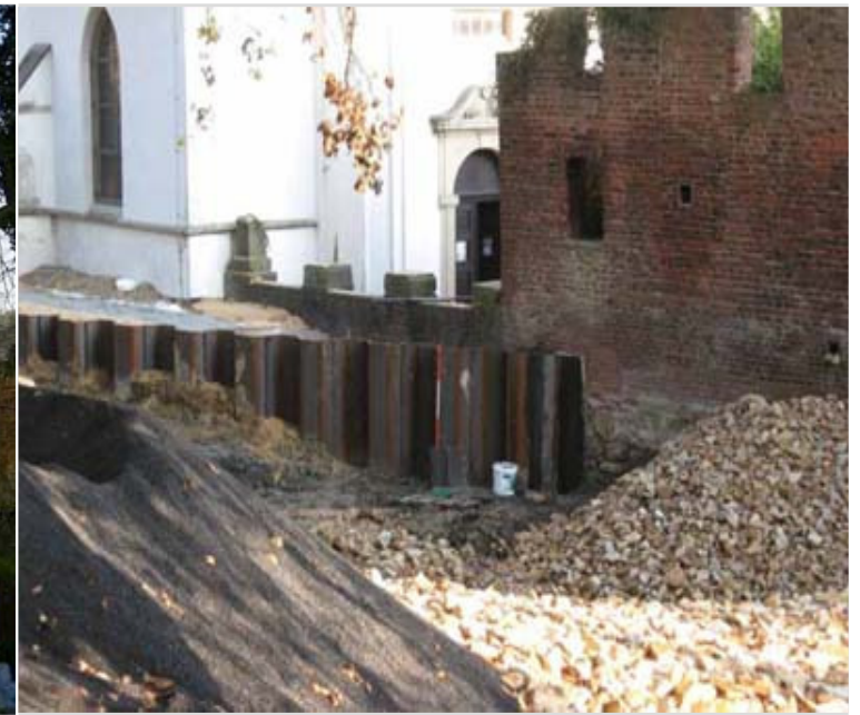
Neue Spundwand direkt neben dem Kapellengebäude
