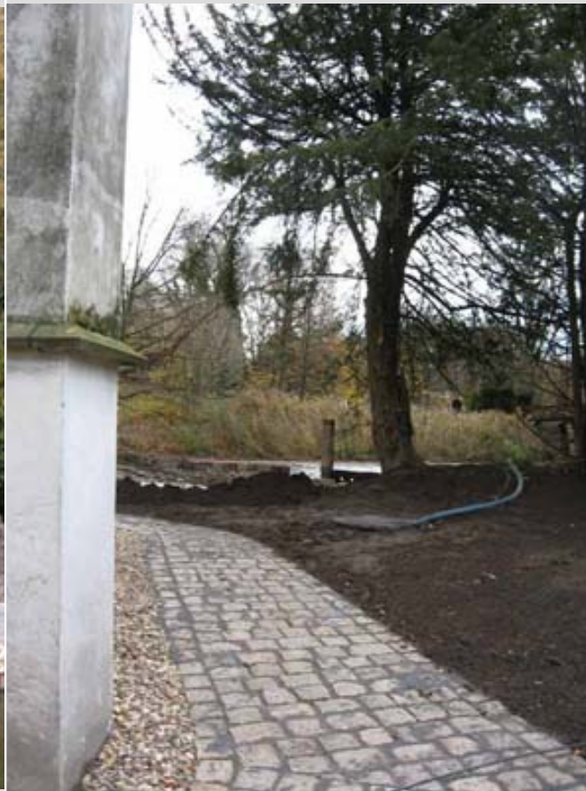
Flutung durch Lücke in alter Spundwand
