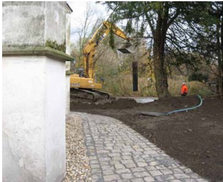
Entfernung der alten Spundwände
