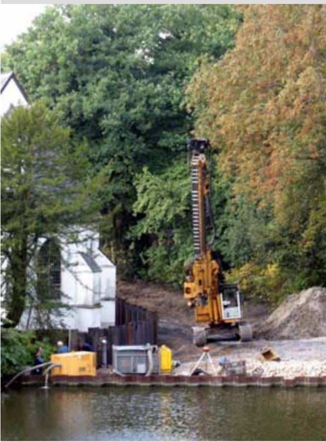
Einrammen der neuen Spundwand
