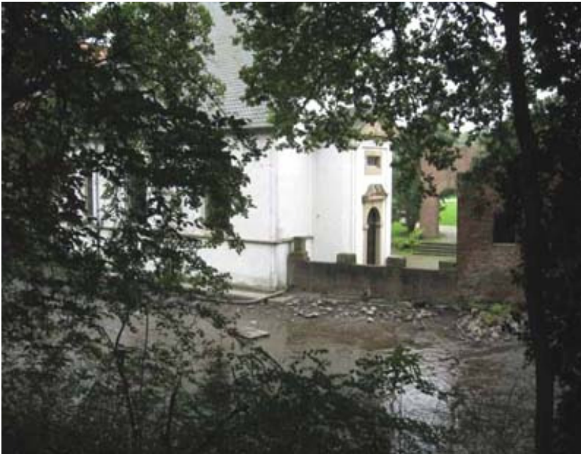
Leergepumpter Schutzbereich zwischen den alten Spundwänden
