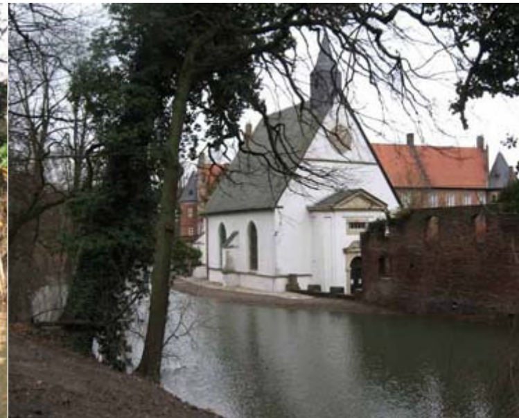
Schlosskapelle nach der Sanierung
