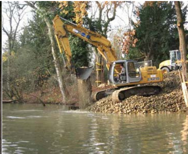
Entfernung der Behelfsaufschüttung
